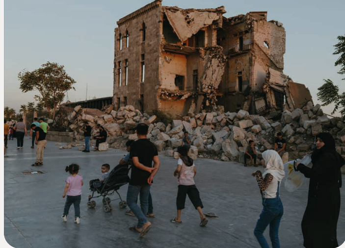
Los edificios dañados en Aleppo, Siria, reflejan el impacto continuo del conflicto en las comunidades
